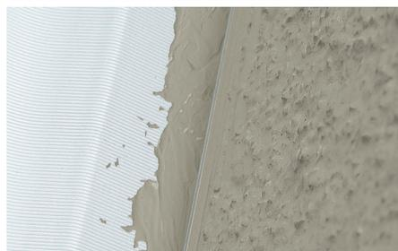
Folienklebebänder aus PE und PVC für den Schutz von Bauteilen vor dem Einputzen. Leicht abrollbar und bei Querrillung sehr leicht von Hand abreißbar. Farbige Bänder für bessere Sichtbarkeit gegen Übersehen von Restverklebungen. PE Bänder verhindern Verfärbungen des Untergrunds und sind auch für Abbeizarbeiten geeignet.
