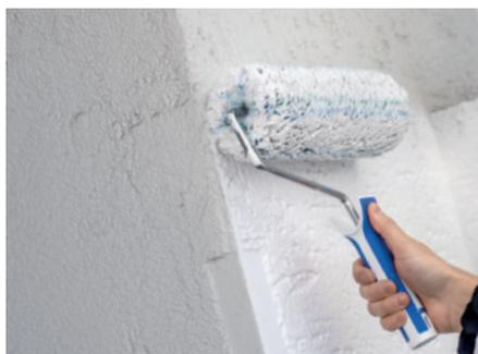
Wand-, Decken- und Fassadenfarben lassen sich bestens mit mittel- bis langflorigen Plüschwalzen verarbeiten. Je gröber der Untergrund, desto länger der Pol des Plüsches.
