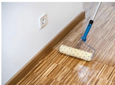
Holzschutz im Sichtbereich gewinnt an Bedeutung und dadurch auch die Pflege mit hochwertigen Anstrichmitteln wie Holzversiegelungen, offenporigen Lasuren, Wetterschutzfarbe, Holzöle und vielem mehr. Klassischerweise werden diese mit Microfaserwalzen aufgetragen, welche bis zu 200 % ihres Eigenvolumens an Farbe aufnehmen und halten können. Hierdurch werden sehr hohe Reichweiten und zügiges Arbeiten ermöglicht.
