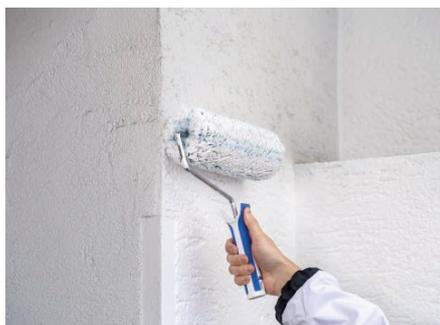
Wand-, Decken- und Fassadenfarben lassen sich bestens mit mittel- bis langflorigen Plüschwalzen verarbeiten. Je gröber der Untergrund, desto länger der Pol des Plüsches. Gepolsterte (gerade laufende Streifen) zur Anwendung auf grobem Putz, thermofusionierte Hartkernwalzen (diagonal laufende Streifen) mit 9-13mm Pol für glatte Wände.
